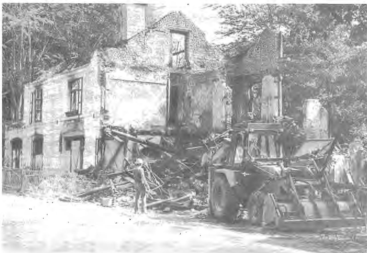
Démolition du bâtiment en juillet 1985.
