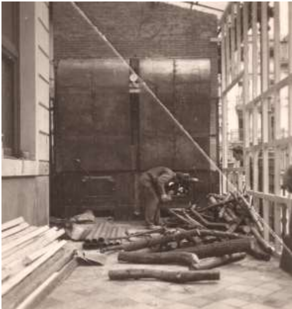
Les chaudières à bois et le système de chauffage à air pulsé (Coll. Musée de la Ville d'eaux)
