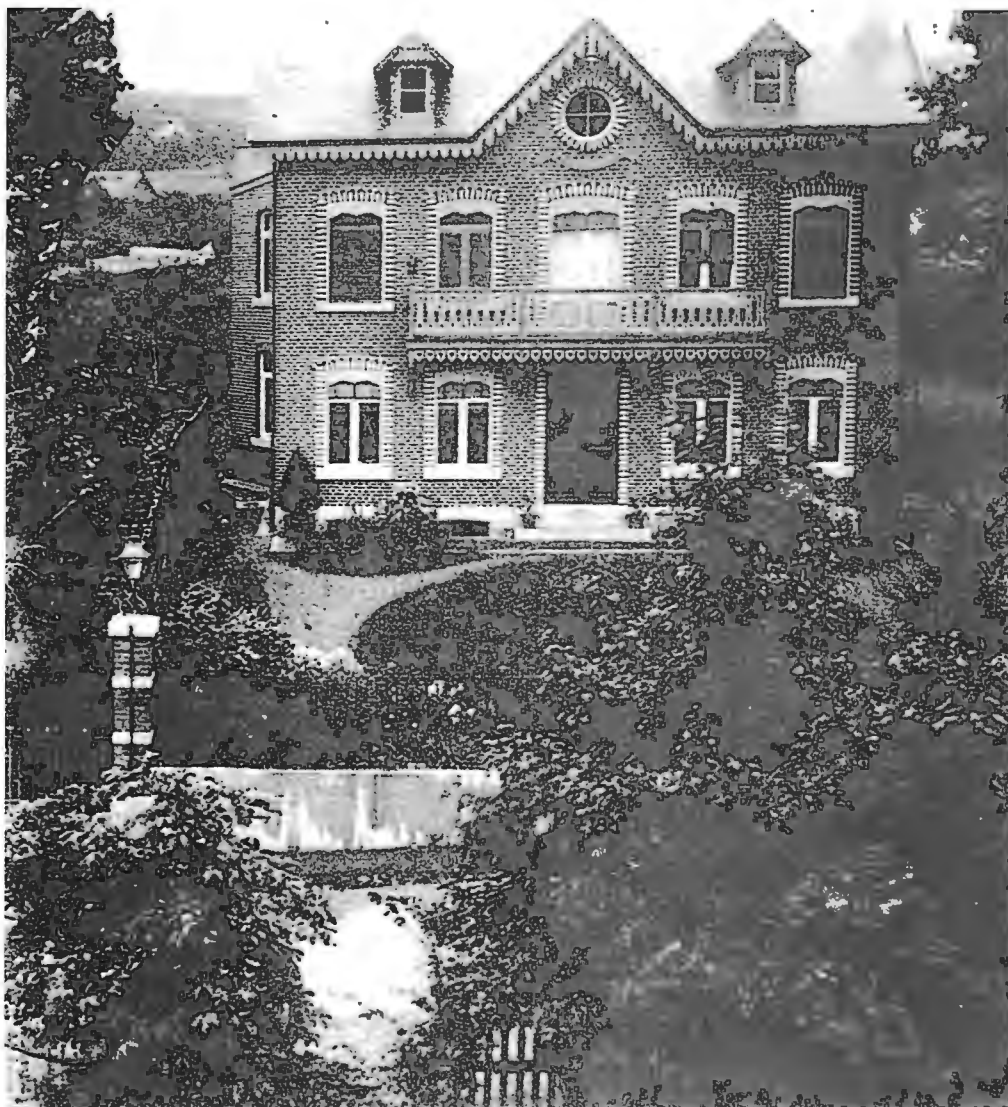
Figure 7 : « Villa des lauriers » 23
