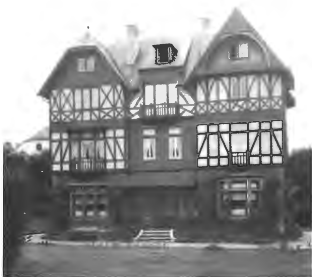
Figure 8 : « Villa le Chaineux » 24 Avenue Clémentine
