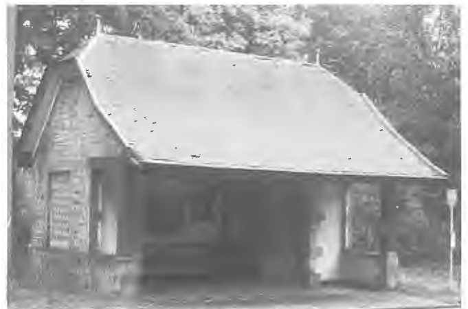
Abri de tram de Balmoral [S.Y. Geuzaine (2003)]
