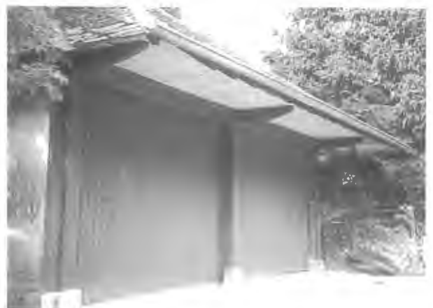
Dave-Sur-Meuse : garage [R. Balau (2002)]
