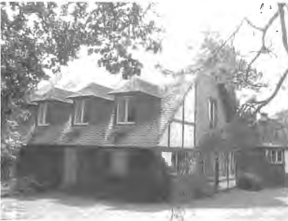
Le Bon Coreux : façades est-nord [S.Y. Geuzaine (2003)]
