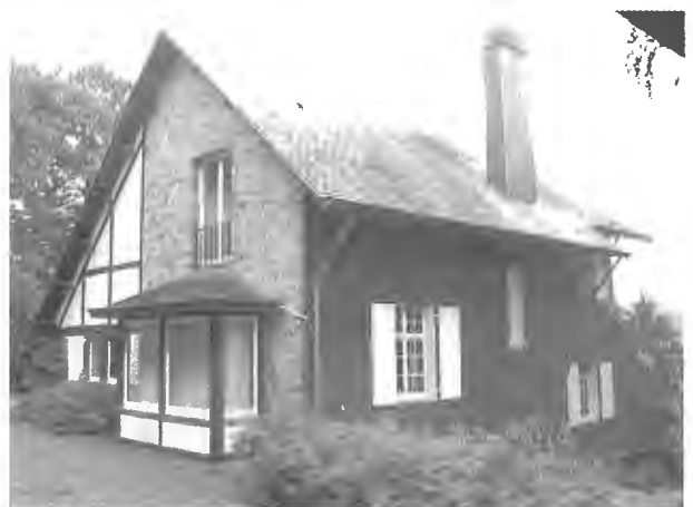
Le Bon Coreux : façades nord-ouest [S.Y. Geuzaine (2003)]
