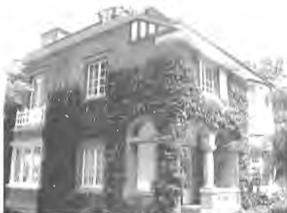
Le Soyeureux (1910) : façades ouest-nord [S.Y. Geuzaine (2003)]
