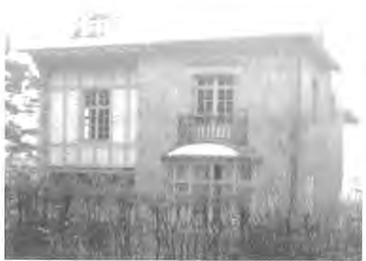
Le Bon Coreux : façade nord [J. Winandy (1968)]
