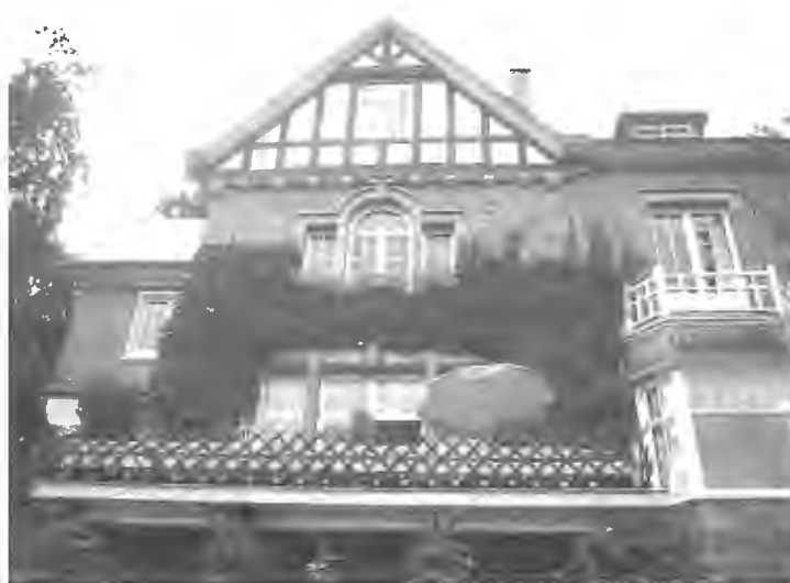
Le Soyeureux : façade sud [S.Y. Geuzaine (2003)]
