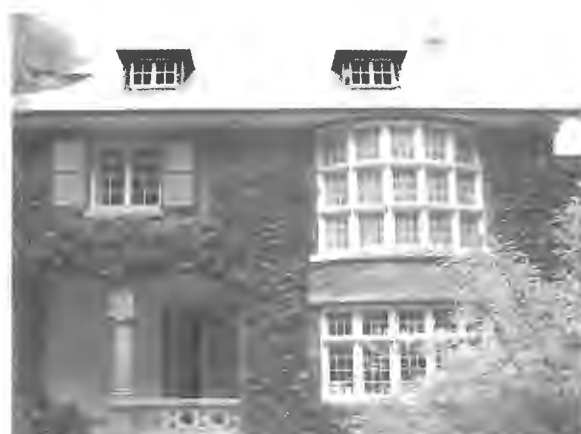
Le Soyeureux : entrée façade nord [S.Y. Geuzaine (2003)]
