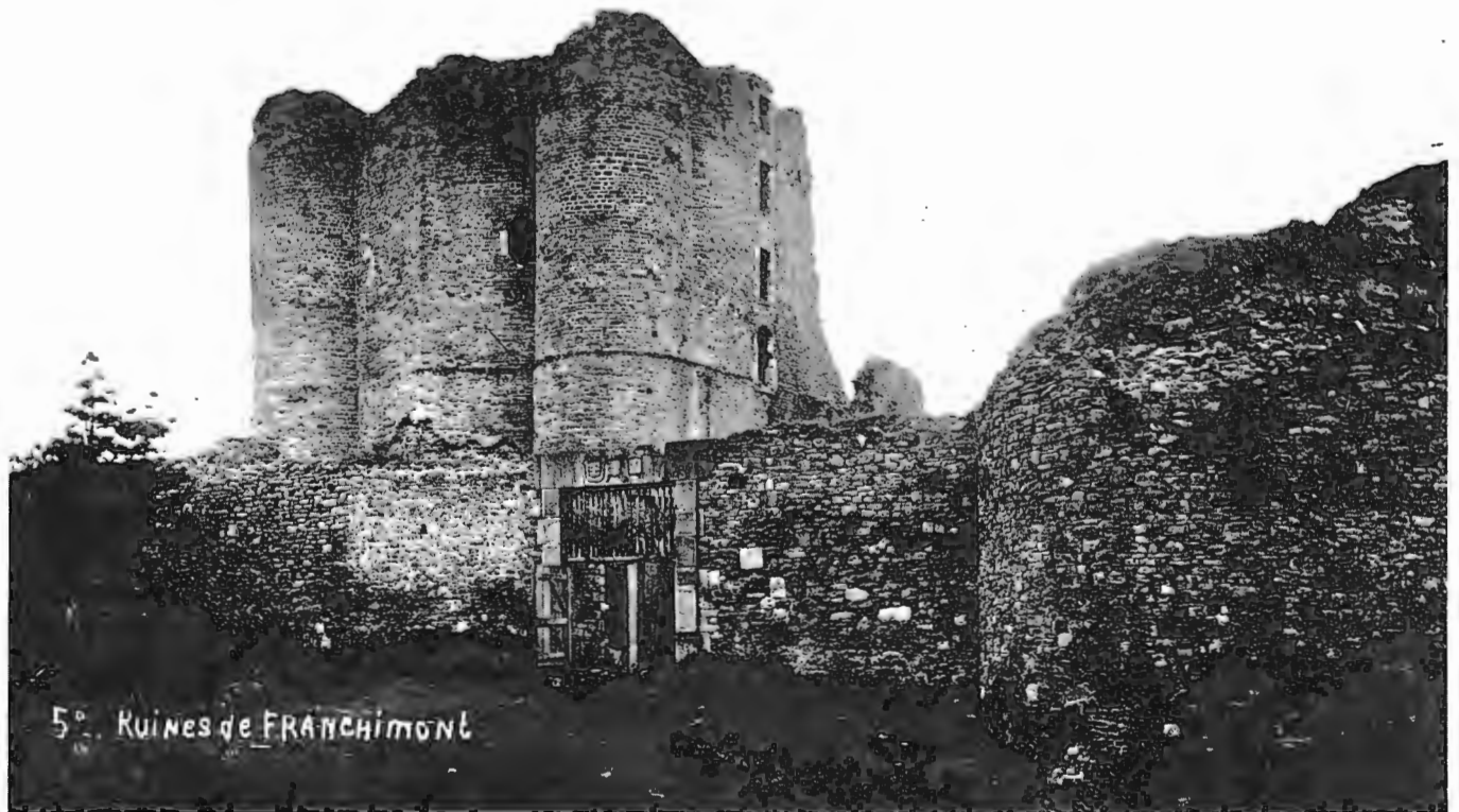
Fig. 7 - Vue extérieure du donjon avec son rhabillage de maçonnerie pleine daté de la fin du XIV e siècle. A droite, ce qui subsiste de la tour d'artillerie (début XVI e siècle ; destruction partielle en 1676) (photo A.C.L.).
