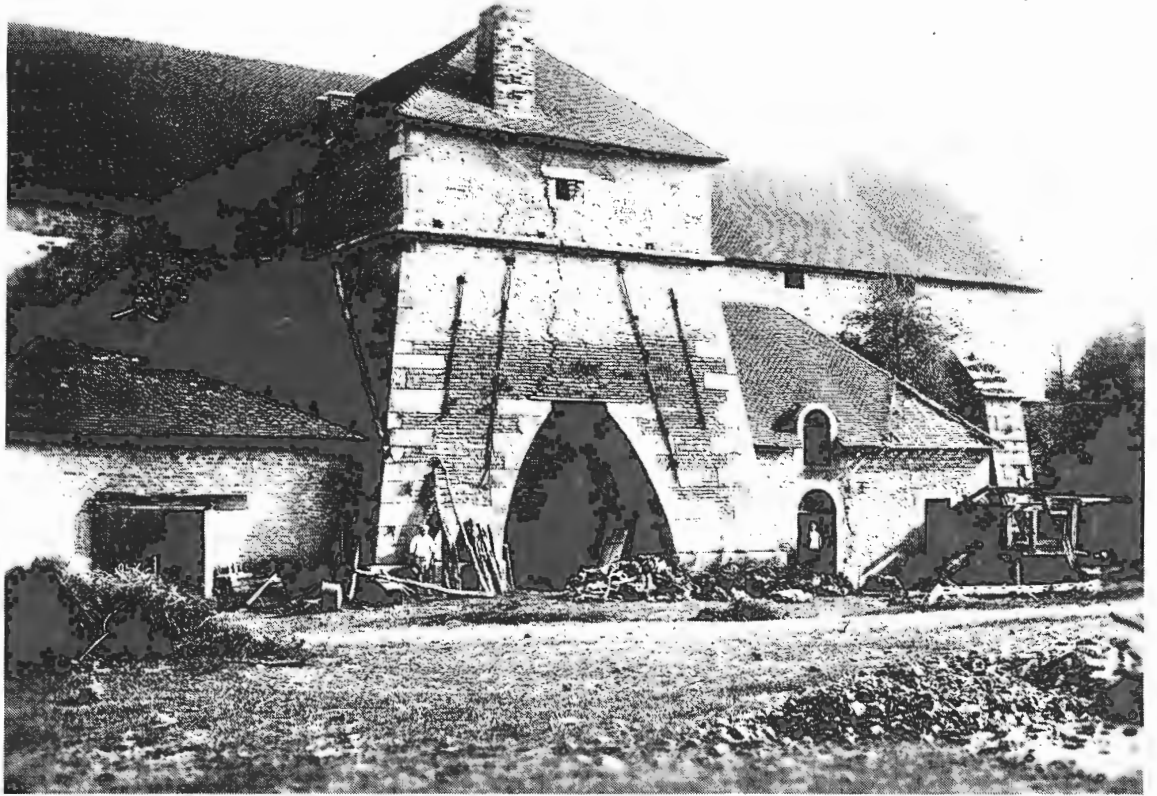
32. Le haut fourneau de la Thuillère près d'Auberive tel qu'il existait encore vers 1900, construit avec des techniques particulières en raison des contraintes mécaniques et thermiques par utilisation des arcs cintrés et d'un appareil robuste bénéficiant d'une longue tradition régionale en stéréotomie c.-à-d. dans la taille et la coupe des pierres et des matériaux de construction.
