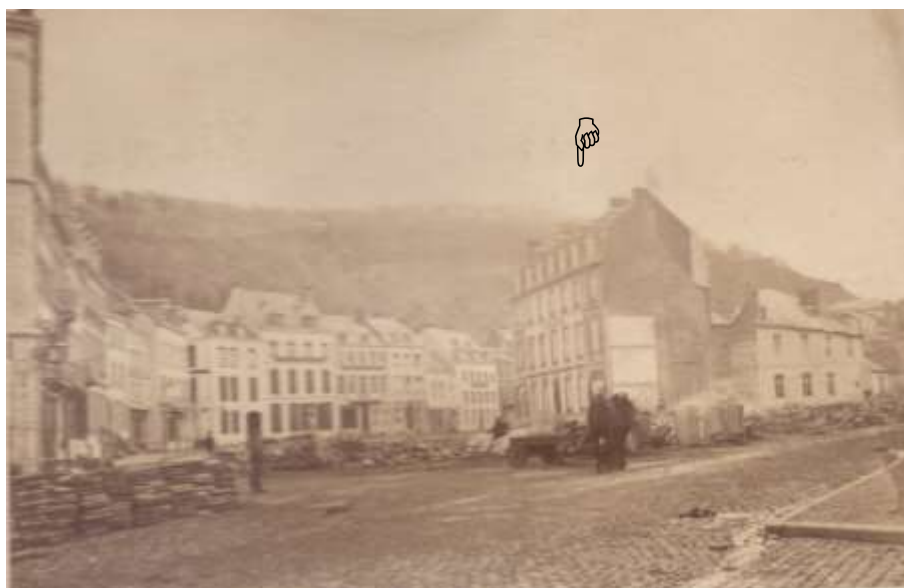
L'entrée de la rue du Marché après la démolition du Pouhon à colonnes et l'Hôtel du Lion noir, premier bâtiment à droite (Coll. Musée de la Ville d'eaux)
