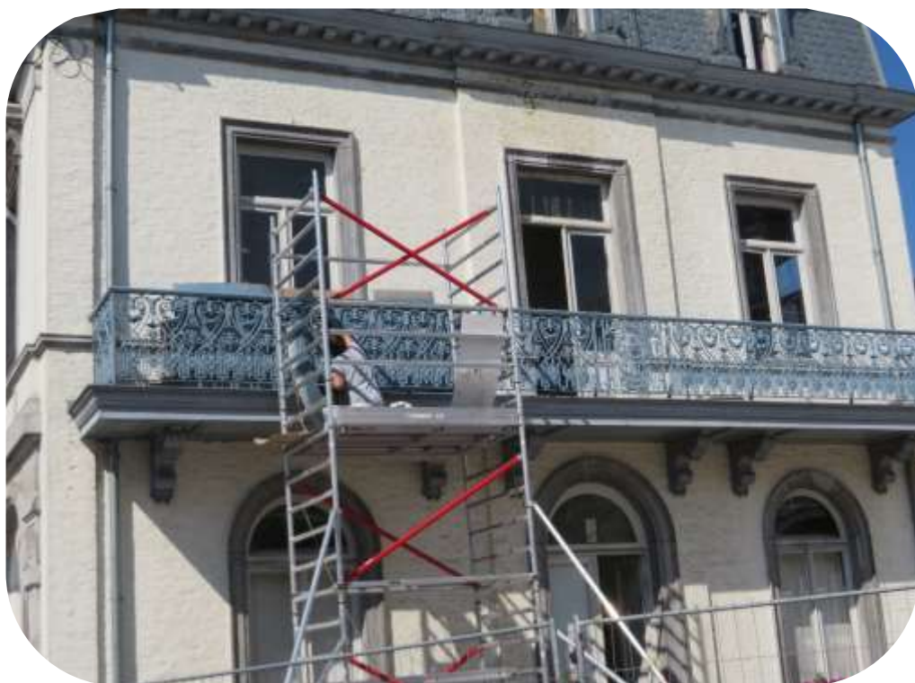
Mise en peinture des ferronneries fixes (galeries et balcons)
