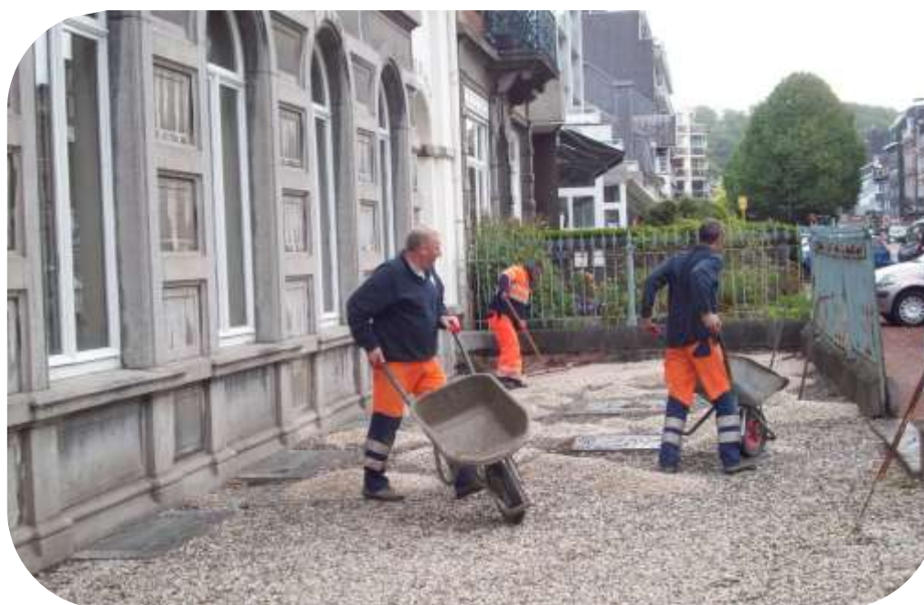
Répartition des 15 tonnes de graviers
