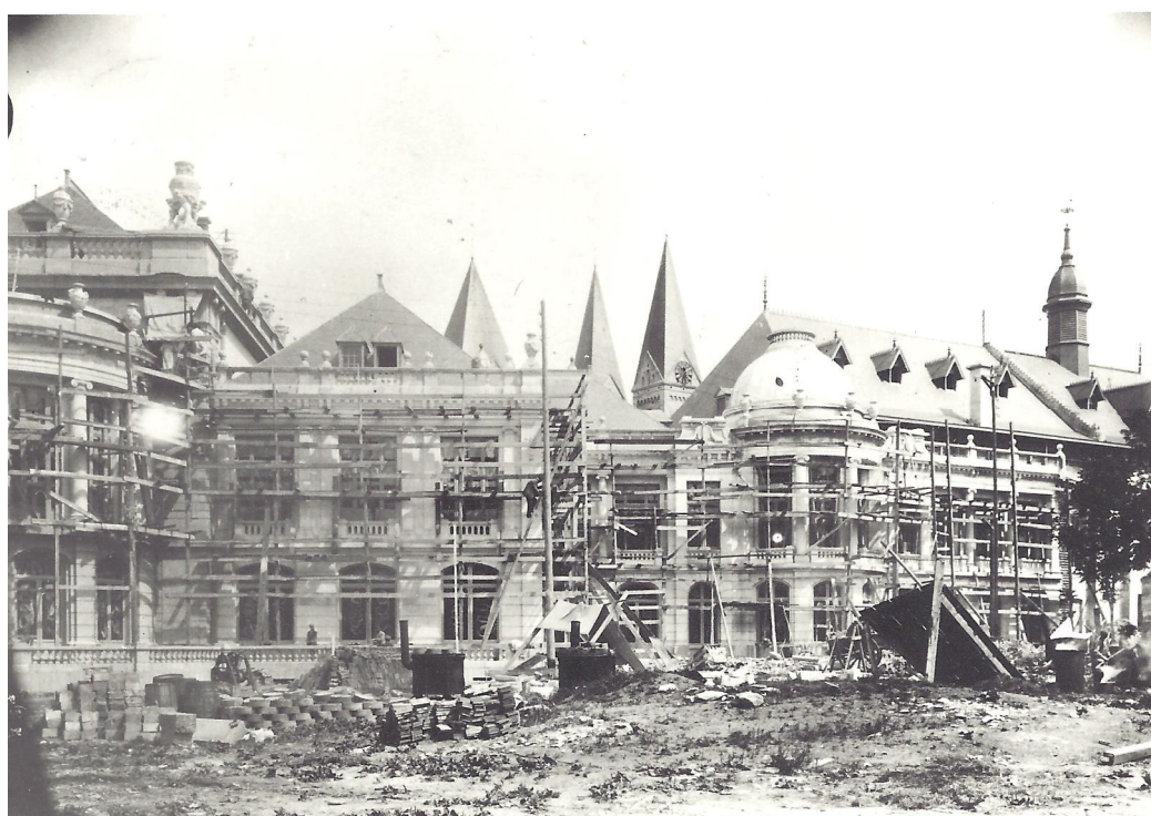
L'ensemble du chantier côté ouest (Coll. Musée de la Ville d'eaux)
