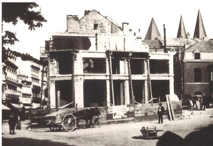
Démolition du bâtiment (pharmacie Leboutte) faisant le coin des rues Royale et Léopold. Sur la gauche, malgré le flou de la photo, on reconnaît la silhouette des maisons de la rue Royale en face du casino (Coll. Musée de la Ville d'eaux)
