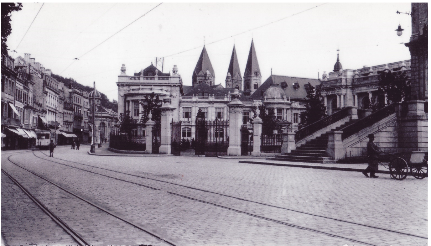
En 1924, vue du Casino et de ses grilles (Coll. Musée de la Ville d'eaux)
