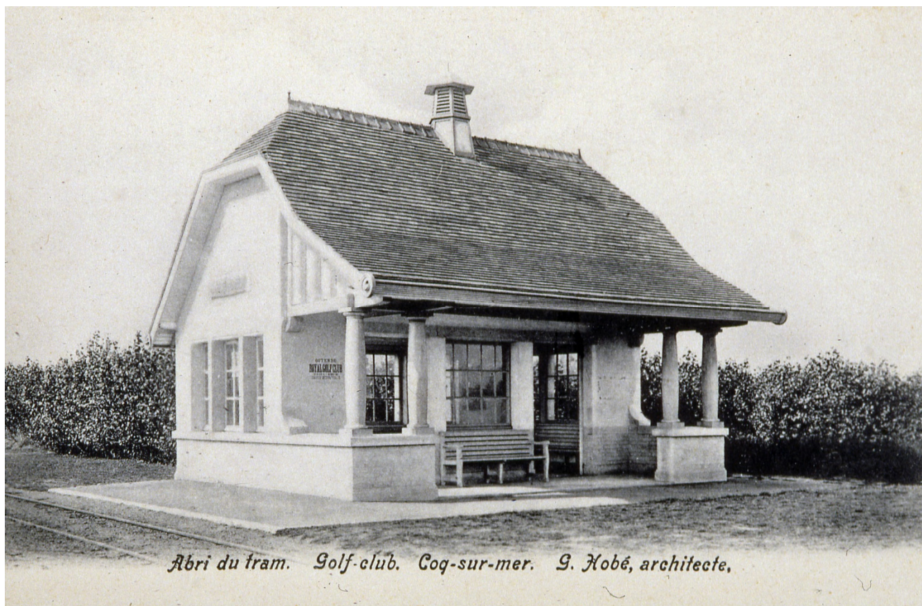
Abri du tram. Golf-club. Coq-sur-mer. G. Hobé, architecte. Carte postale (coll. part.)
